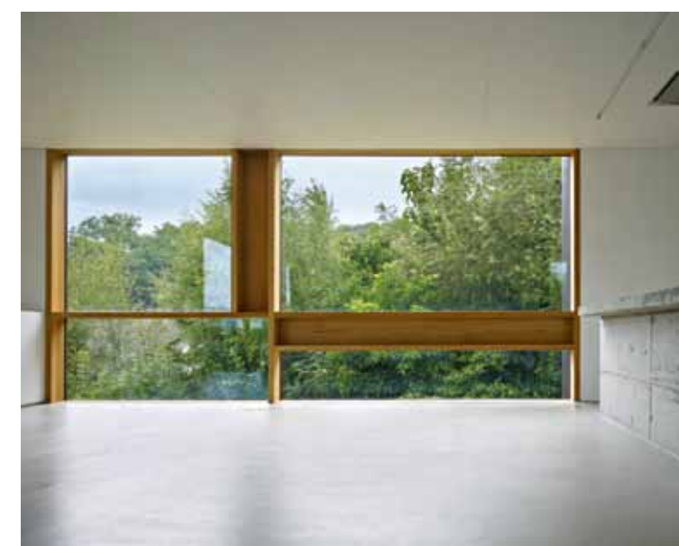
Blick nach Westen. Das wie ein Mondrian-Bild geteilte Fenster ist dreifach verglast.
